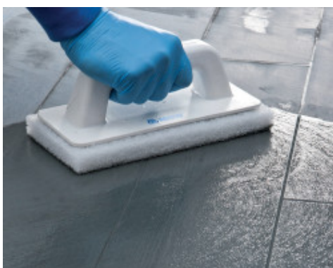
Čištění a konečná úprava spár s pomocí Scotch-Brite®
