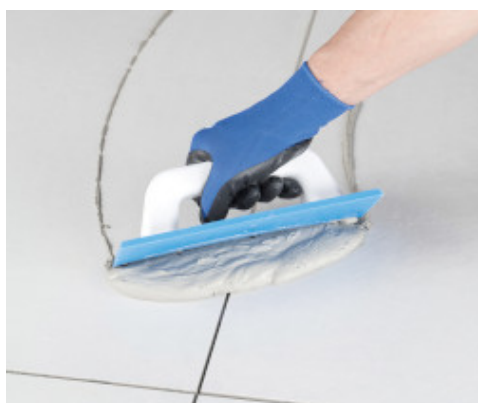
Nanášení Ultracoloru Plus gumovou stěrkou
