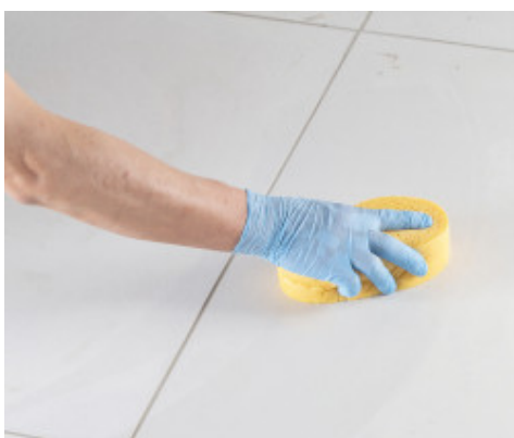
Čištění a konečná úprava spár tvrdou houbou z celulózy
